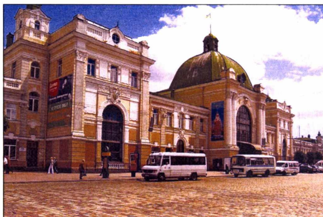
Dworzec kolejowy w Stanisławowie
